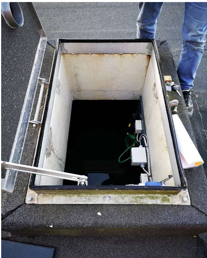
6 Dæksel til den nye rentvandstank - bemærk kontakt til elektronisk alarm (TH)
