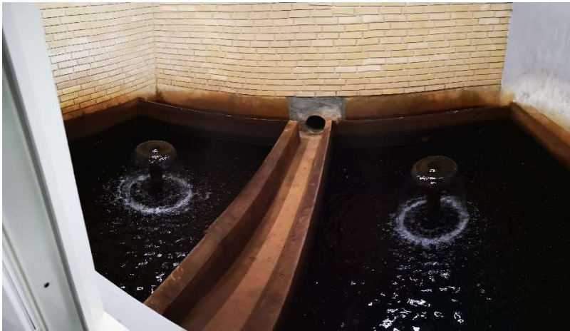
5 de åbne efterfiltre - ovenfra og nedefra - bemærk karret er helt tæt efter renoveringen i 2016
